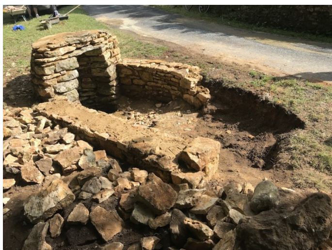
Restauration en cours
