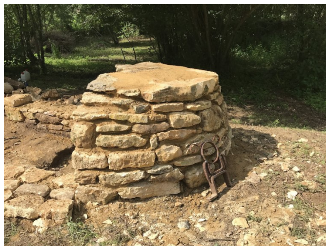
Aboutissement des travaux
